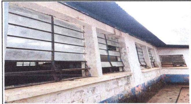
Foto 4: Se observa en area de ventaneria piezas de vidrios en mal estado, pintura en desprendimiento y metales oxidados en modulo 2
