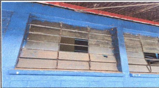
Foto 1: Se observa el mal estado de las ventanas y vidrios en el modulo 1.
