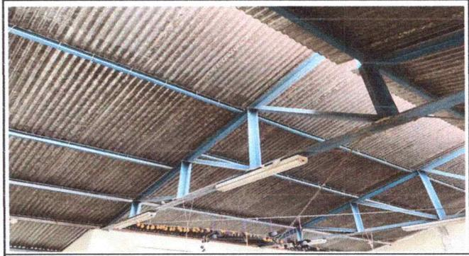
Foto 2: Se observa el deterioro de la estructura portante en el modulo 1.
