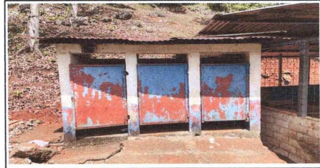
Foto 6: Se observa techo en mal estado y pintura en desprendimiento en modulo 3
