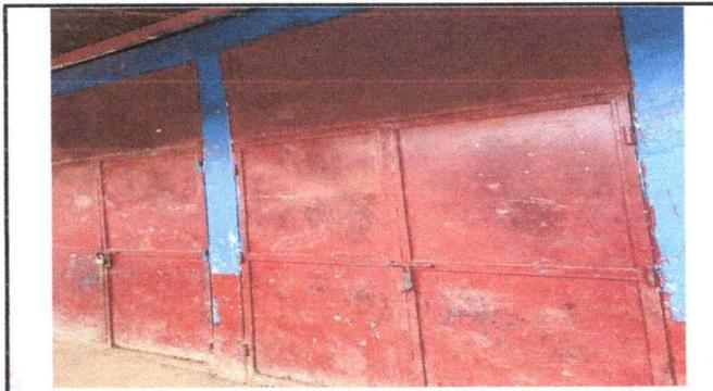
Foto 3: Se observa el mal estado de las puertas, (muy oxidadas) en el modulo 2
